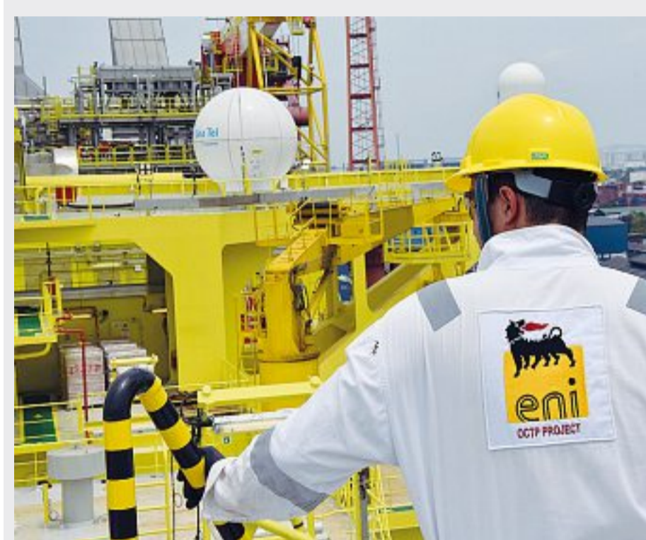
Energia L'Eni intende proseguire sulla strada delle rinnovabili. Nella foto un operaio al lavoro in Ghana
