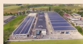
Impianto fotovoltaico da 2,2 MW
