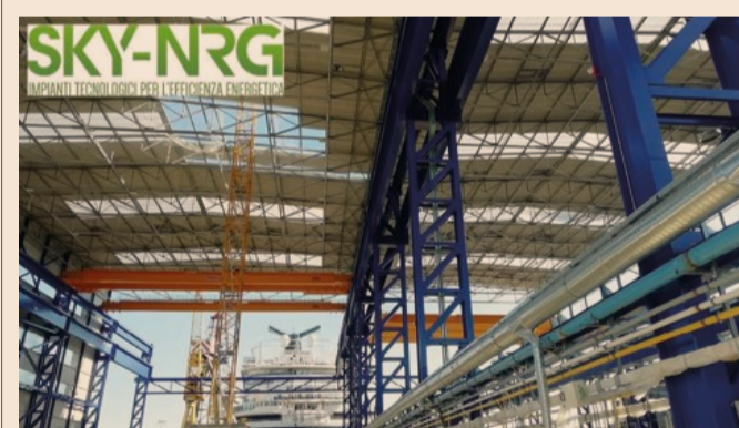
Nuovo stabilimento a Marghera (VE)
